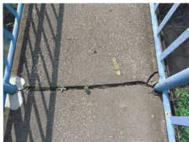
Detail trhliny – šířka až 20 mm.
