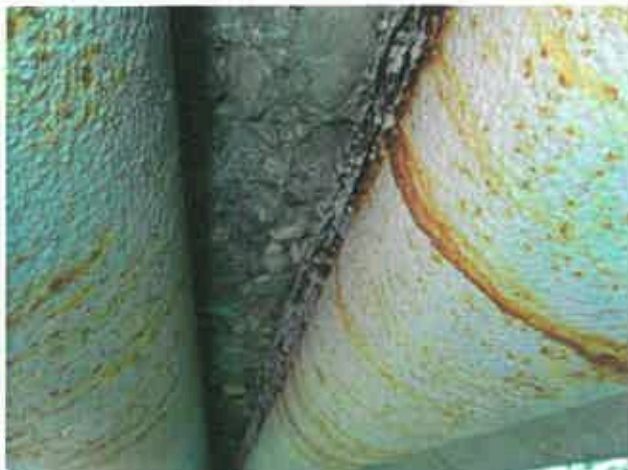
Pole 3 – koroze a rozpad horních částí trub na styku s mostovkou. Tloušťka korozních šupin 15-20 mm.
