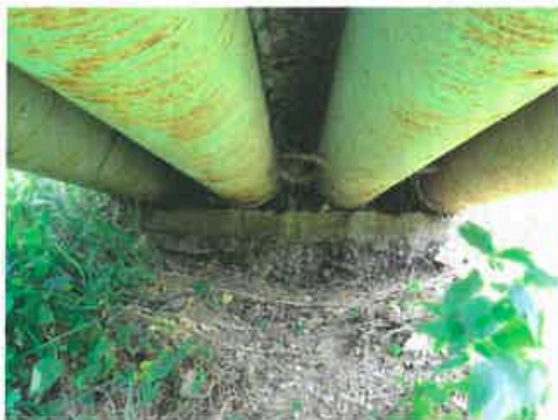
Opěra 1. Rozpad betonu spodní části opěry.
