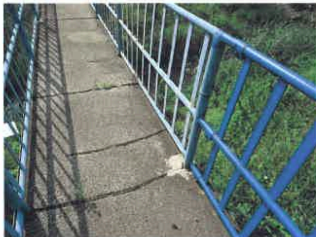
Trhliny v krytu z litého asfaltu
