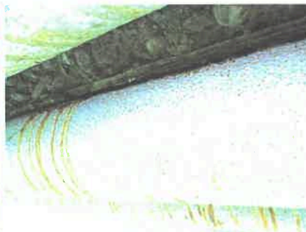
Pole 2 – koroze a rozpad horních částí trub na styku s mostovkou
