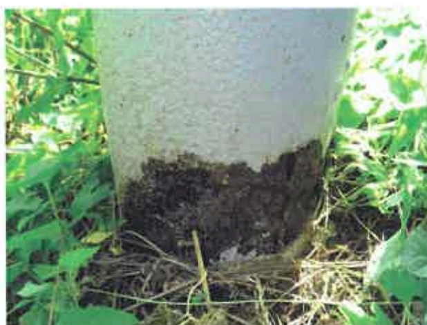
Detail koroze stojky podpěry 3
