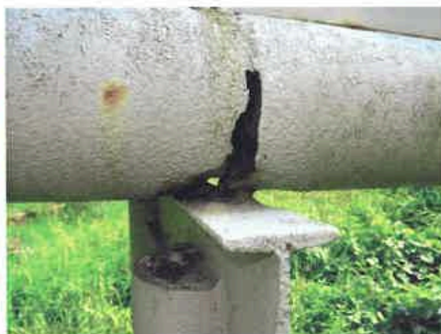
Zkorodovaný spoj trub nad podpěrou 3
