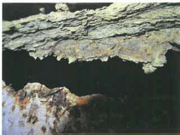
Pole 2 – koroze a rozpad horních částí trub na styku s mostovkou – detail. Rozsah koroze – dl. 1,40 m, šířka až 20 mm.
