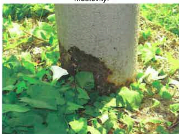
Podpěra 2 – detail koroze stojky
