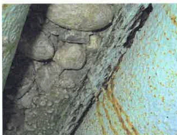
Pole 2 – koroze a rozpad horních částí trub na styku s mostovkou
